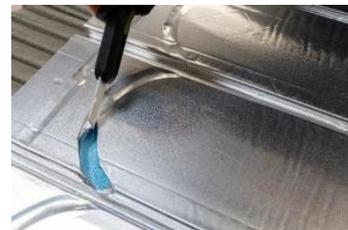
Bei Stäbchenparkett wird eine 12 mm dicke Spanplatte mit Parkettkleber vollflächig verklebt oder mit einer mindestens 8 mm dicken Lage Bodenspachtelmasse. Wenn Bodenspachtelmasse verwendet wird, muss das Aluminium zuerst mit grundiert werden.
