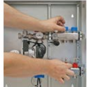
8. Alle Ventile und Durchflussmengenmesser öffnen. Plombierkappen montieren und die Kugelhähne öffnen.
