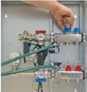
5. Zu spülenden Kreis öffnen und alle anderen Kreise schließen. Wasserzulauf öffnen.
