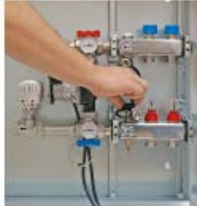
2. Füll- u. Entleerhähne leicht öffnen,
