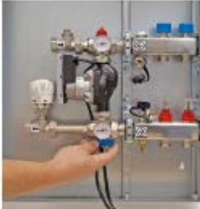
1. Kugelhähne schließen,
