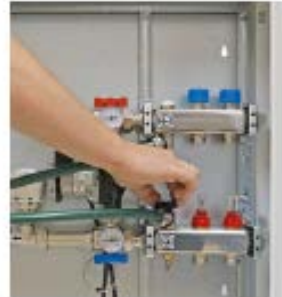
7. Wasserzulauf beenden. Füll- und Entleerhähne schließen. Schläuche abnehmen und die Kappen montieren.
